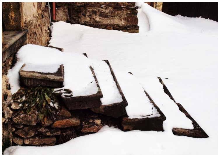
Obr. 3 Schodiště C před jižním vstupem do loď kostela.
