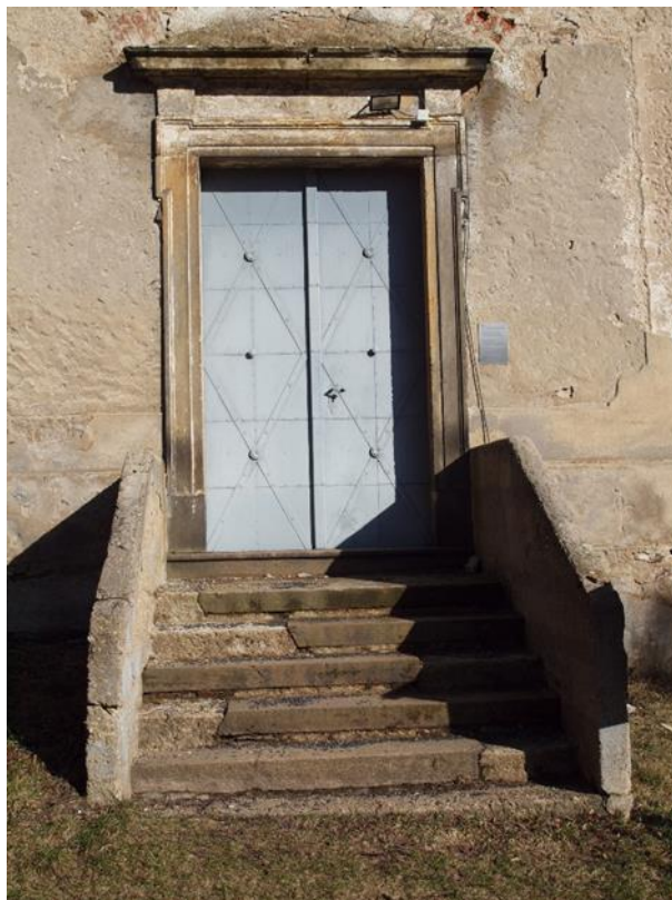
Obr. 1 Schodiště A před západním hlavním vstupem do kostela.
